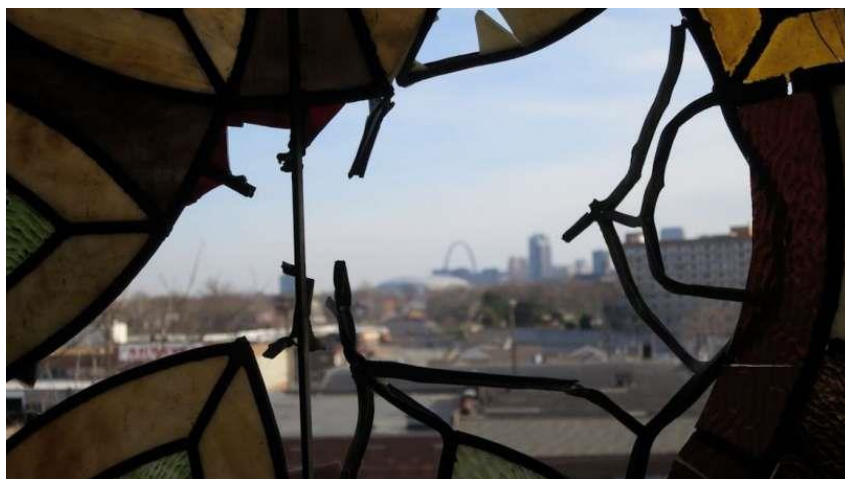
La vetrata distrutta della chiesa di Dieforf
